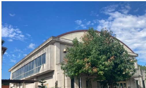
旧東志和小学校体育館(外観)
