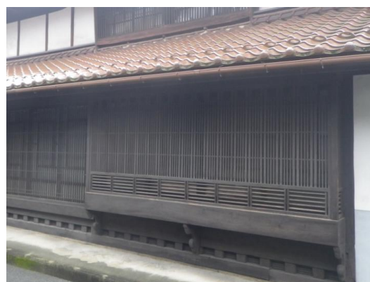
榎野家住宅主屋出格子(北西から)
