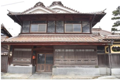
伊原家住宅主屋外観(北から)
