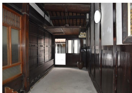
榎野家住宅主屋内部(土間から玄関)
