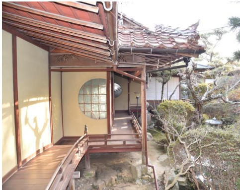
伊原家住宅主屋洗面所から風呂(北から)
