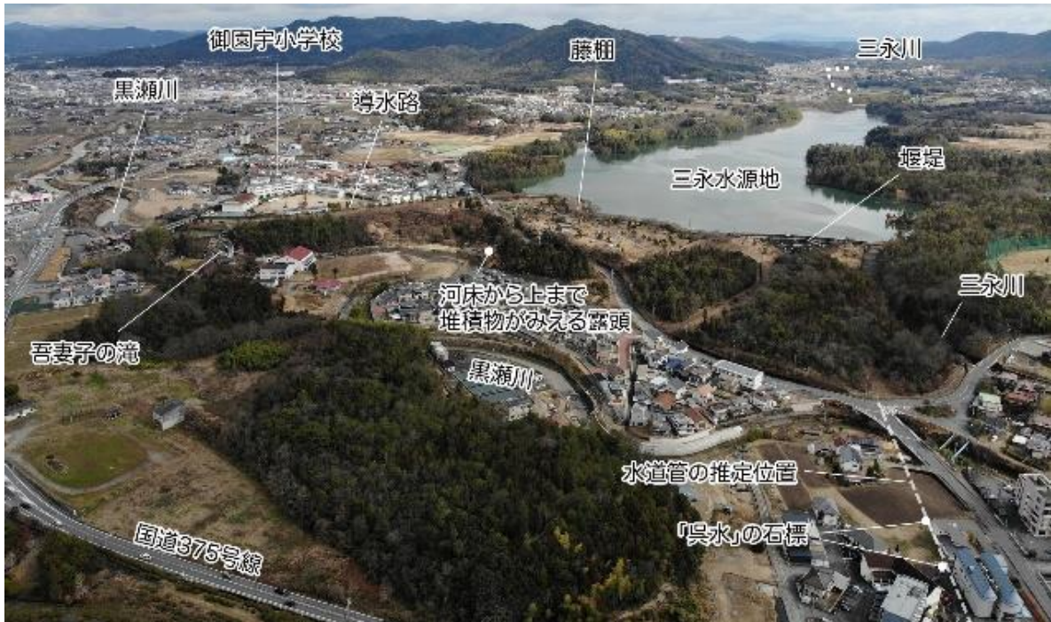
図 2 ドローン撮影による吾妻子の滝周辺の空中写真
