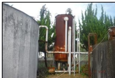
老朽化が進んだ住宅団地の大型浄化槽の様子
