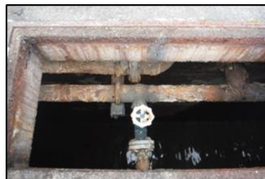
老朽化が進んだ住宅団地の大型浄化槽の様子
