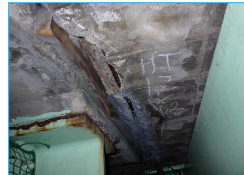
鉄筋の腐食が進み剥落の恐れがある床版
