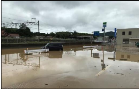
杵原川(中島地区) 浸水被害
