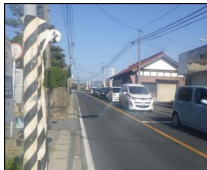
国道375号 歩道未整備区間
