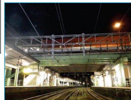
【JR跨線橋 互栄橋】▼
