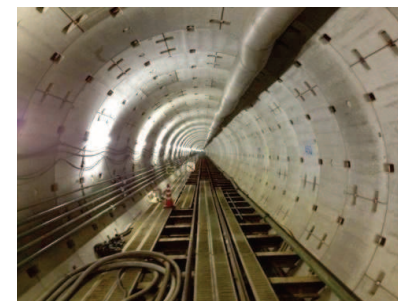
雨水幹線管渠の整備
