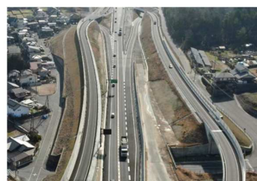
国道2号安芸バイパス
