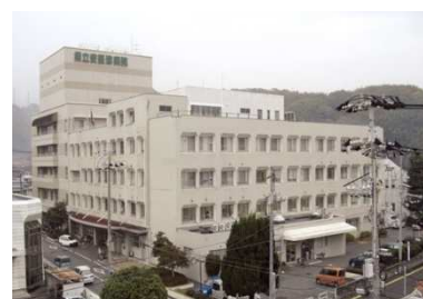
県立安芸津病院
