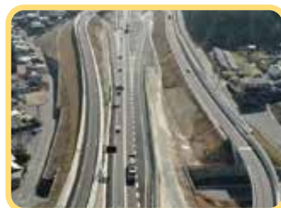
国道2号安芸バイパス
