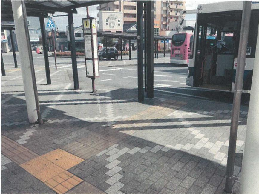
図 12 バス乗車口まで設置された誘導用ブロック（西条駅）
