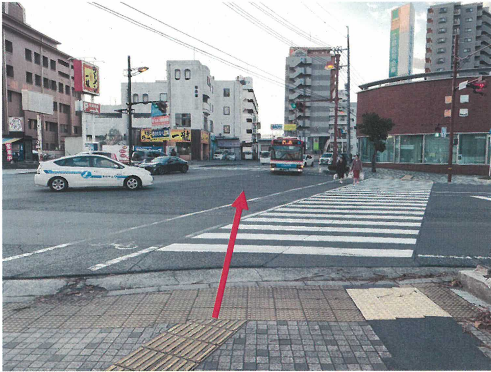
図 1 6 東広島警察署交差点の点状ブロック誘導方向の誤り
