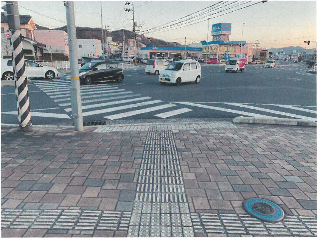
図 4 9 円城寺交差点横断歩道の誘導用ブロック（筆者撮影）
