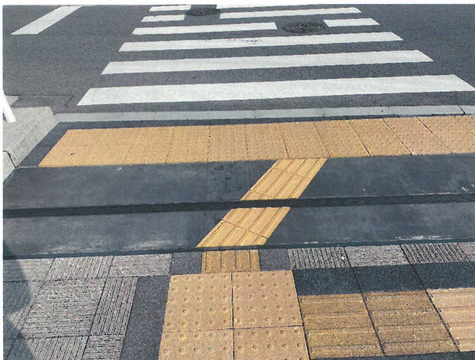
図7 誘導方向が誤っている誘導用ブロック
