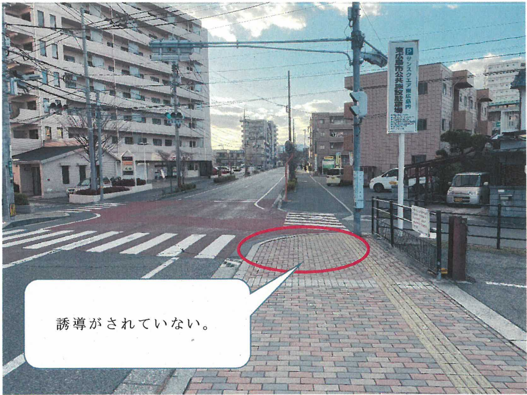
図 3 5 西条西本町交差点の横断歩道
