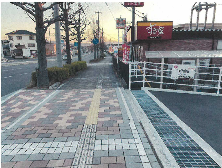
図 1 - 2 国道 375 線における誘導用ブロック改善箇所 (どちらも筆者撮影)
