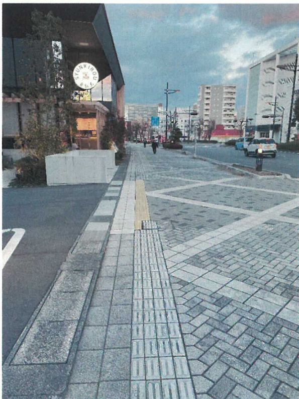
図 1 - 1 ブールバールにおける誘導用ブロック改善箇所
