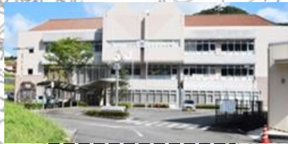
東広島市河内支所
