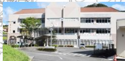
東広島市河内支所
