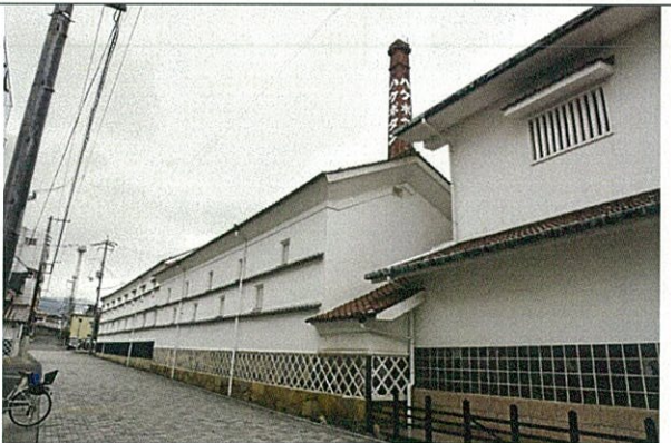
延宝蔵(中央:㉒南端棟、奥:㉓北端棟)
