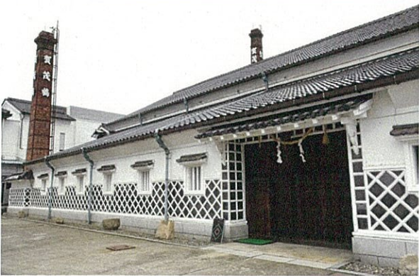
③二号蔵(東西棟)・⑦二号蔵煙突
