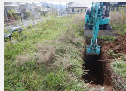
写真 2-3 試掘調査の様子
