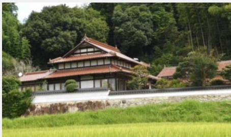
写真 3-34 居蔵造の民家
