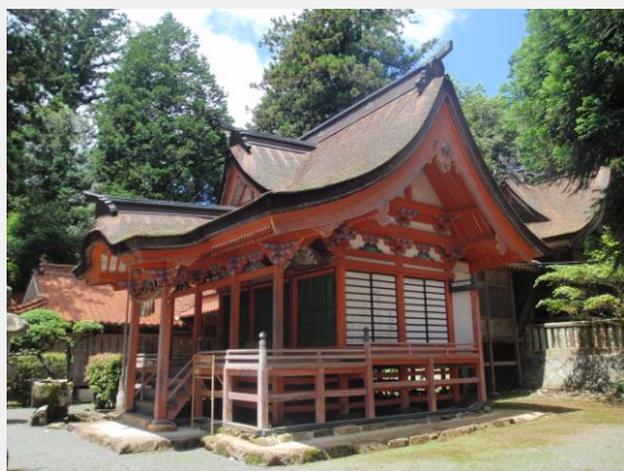
写真 3-32 市重要文化財 本宮八幡神社社殿（拝殿）
