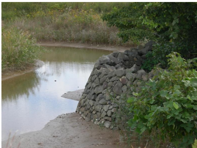
写真 4-37 二馬手塩田の樋門跡 (安芸津町)
