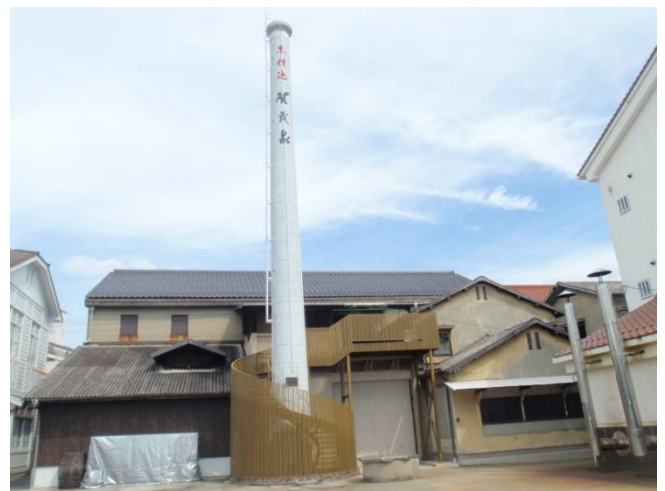
写真 4-44 旧広島県醸造試験場西条支場醸造蔵 （西条上市町）
