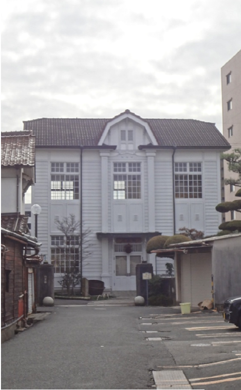
旧広島県西条清酒醸造支場本館(S3)
