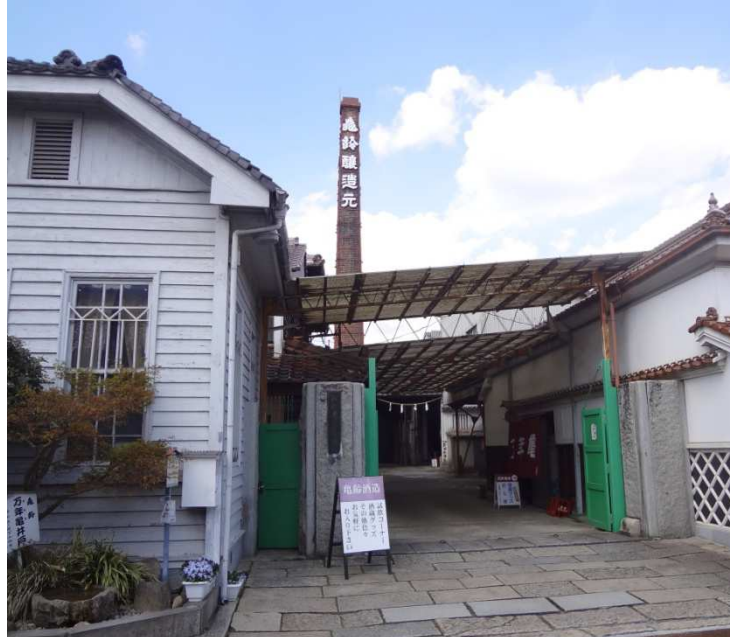
亀齢酒造(株) 洋館、1号蔵煙突、門柱
