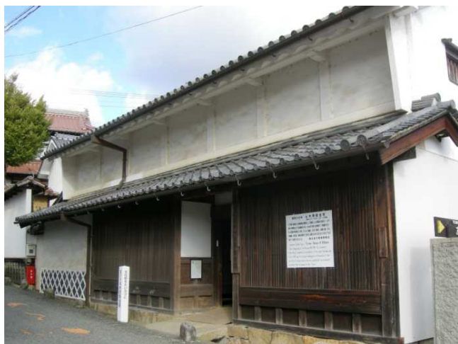
写真 2-1 重要文化財 旧木原家住宅(高屋町:表 2-1・5)
