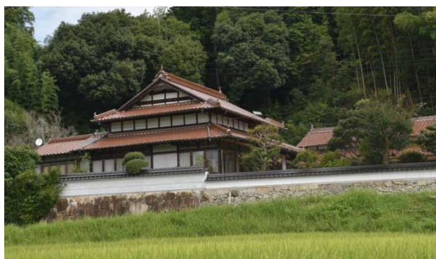
写真 4-32 居蔵造りの民家
