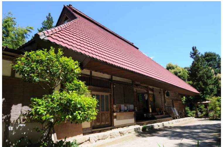
写真 3-2 市重要文化財 並瀧寺庫裏(志和町)
