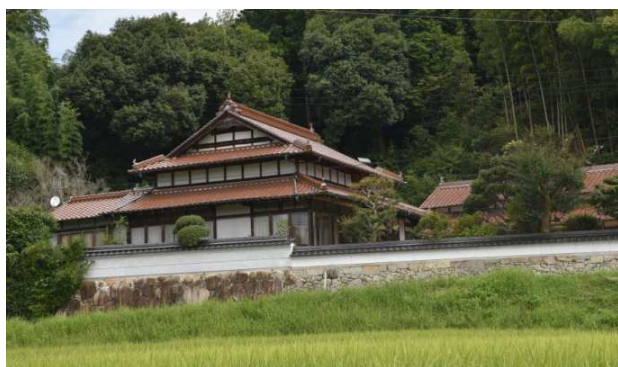
写真 4-32 居蔵造りの民家
