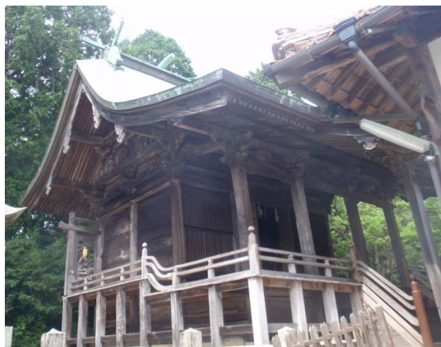
写真 4-28 福岡八幡神社本殿(高屋町)
