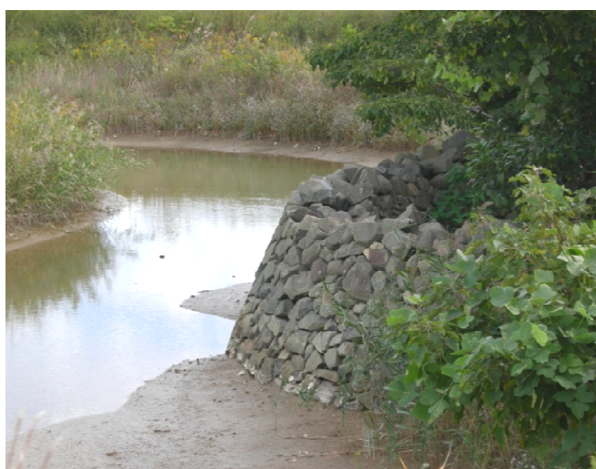
写真 4-37 二馬手塩田の樋門跡(安芸津町)
