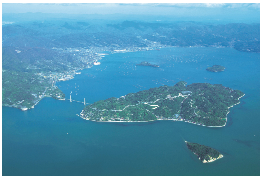
写真 4-34 安芸津町空中写真
