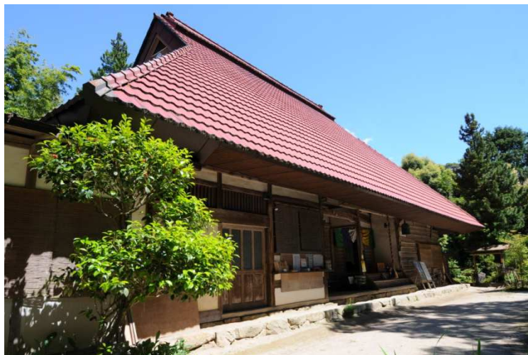
写真 3-2 市重要文化財 並瀧寺庫裏(志和町)
