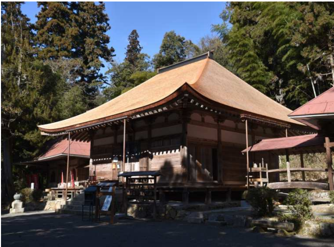
写真 4-17 竹林寺本堂(河内町)
