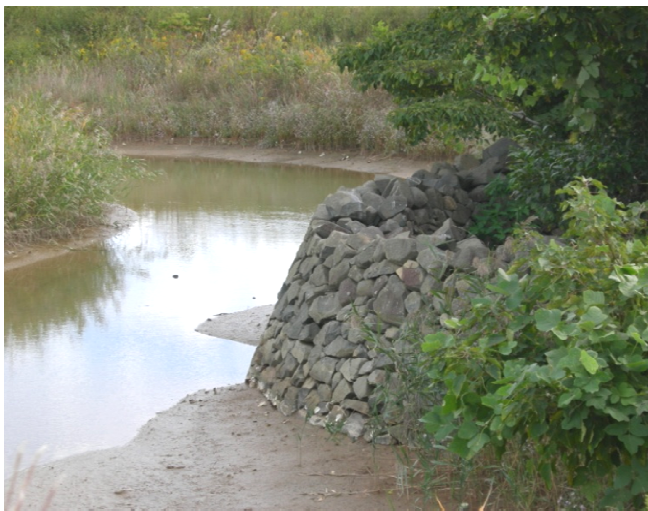
写真 4-37 二馬手塩田の樋門跡(安芸津町)
