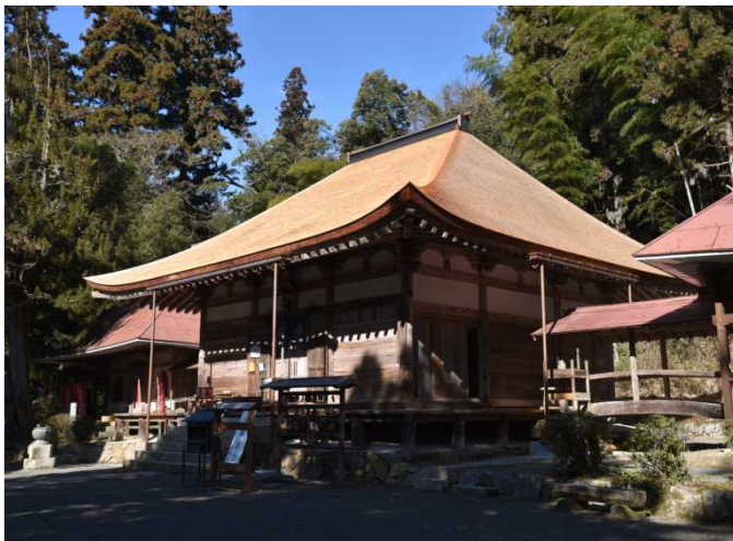
写真 4-17 竹林寺本堂(河内町)
