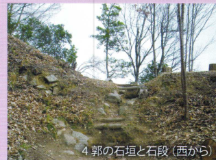
4郭の石垣と石段(西から)
