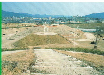
▲整備後の土輪
