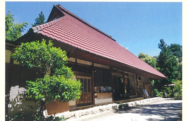
並瀧寺庫裏（北西から）
