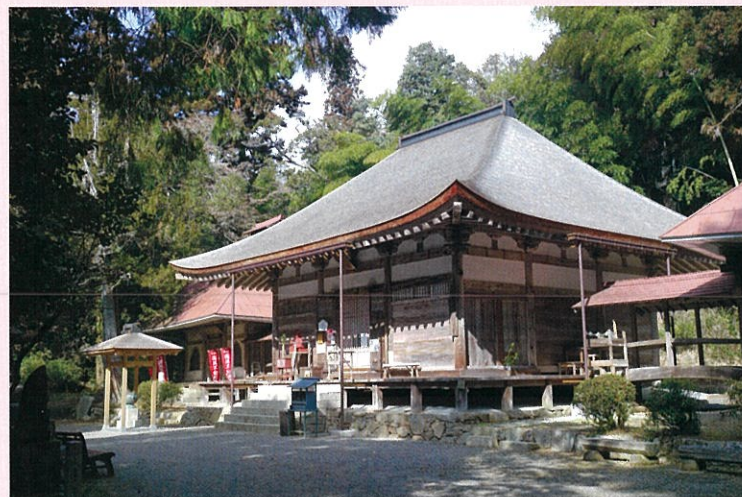
竹林寺本堂（南東から）
