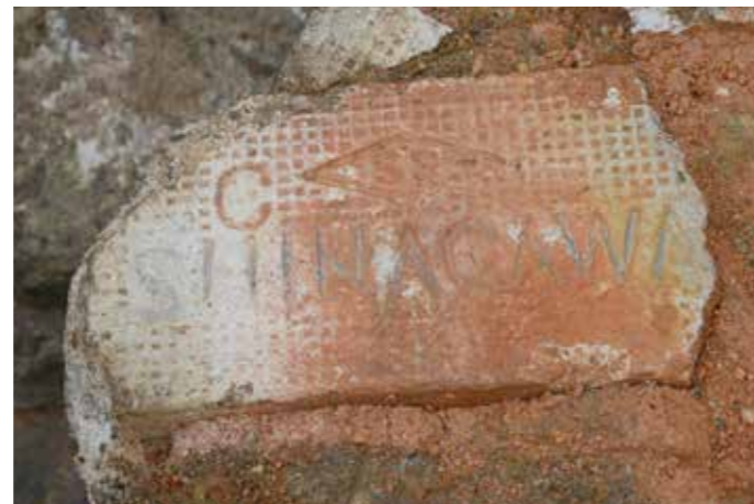
写真3 釜場に使用されていた刻銘入りの耐火レンガ
