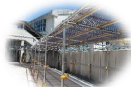
体育館への屋外通路
